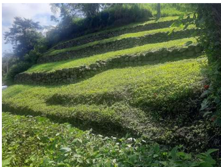
Nota: imagen de los muros de contención con sus respectivos andenes
