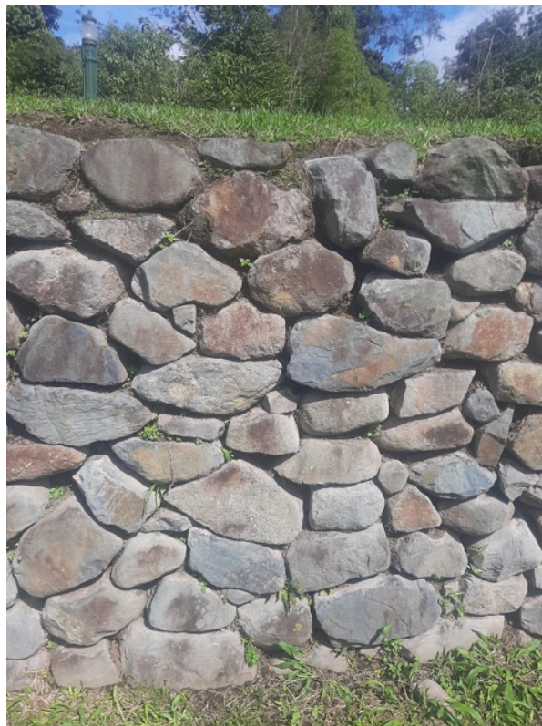
Nota: imagen de paramento externo de un muro de contención.
